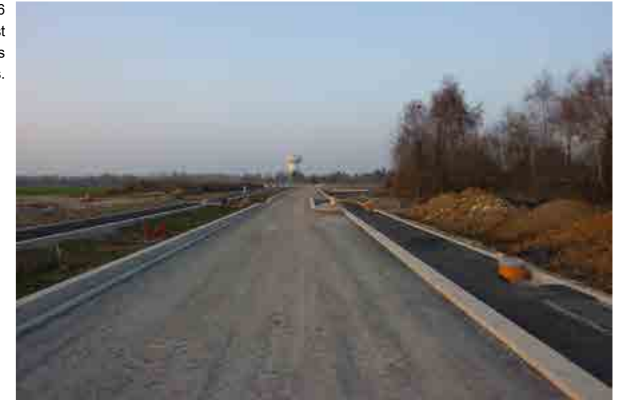
Les premières voiries de l'écoquartier sortent de terre.
