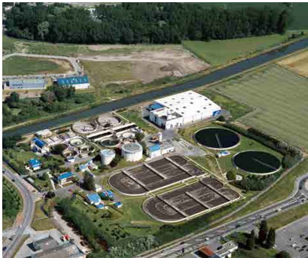
La station d'épuration de Douai-Fort de Scarpe.
