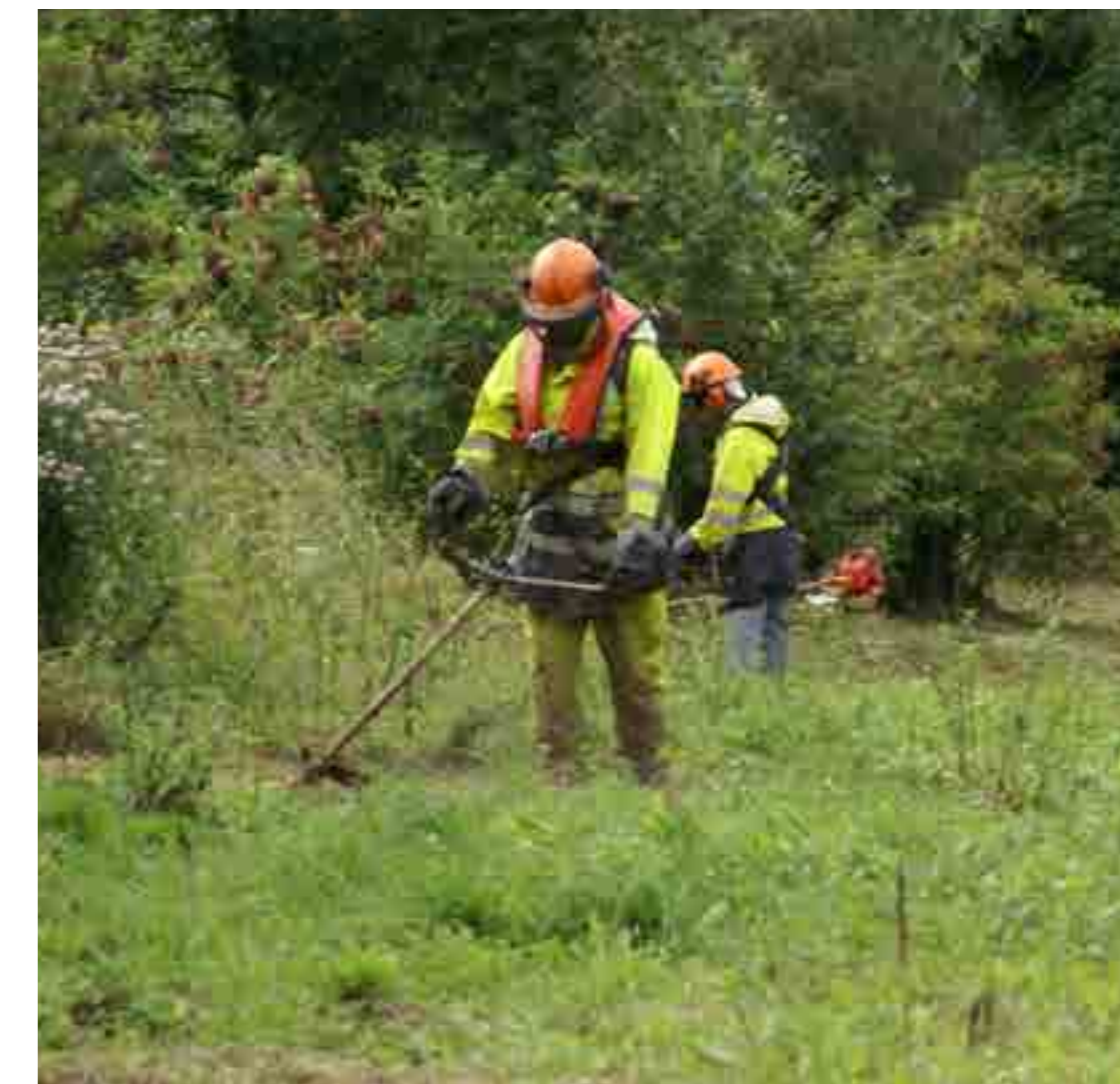
Opération de débroussaillage.
