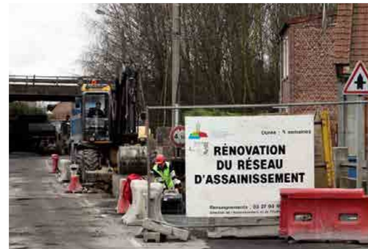
Opération de rénovation du réseau d'assainissement.
