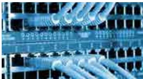
Réseaux de télécommunication et de vidéocommunication
