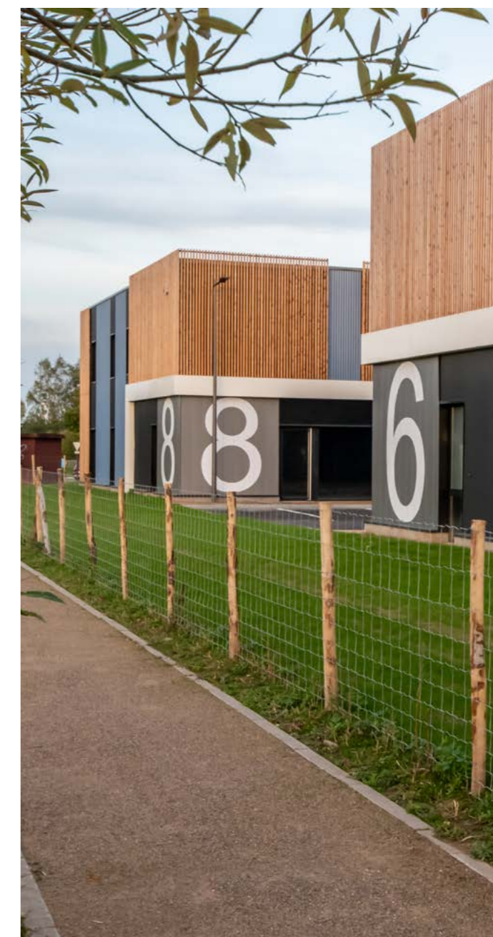
L'Ecopark s'agrandit avec la construction de 3 bâtiments.
