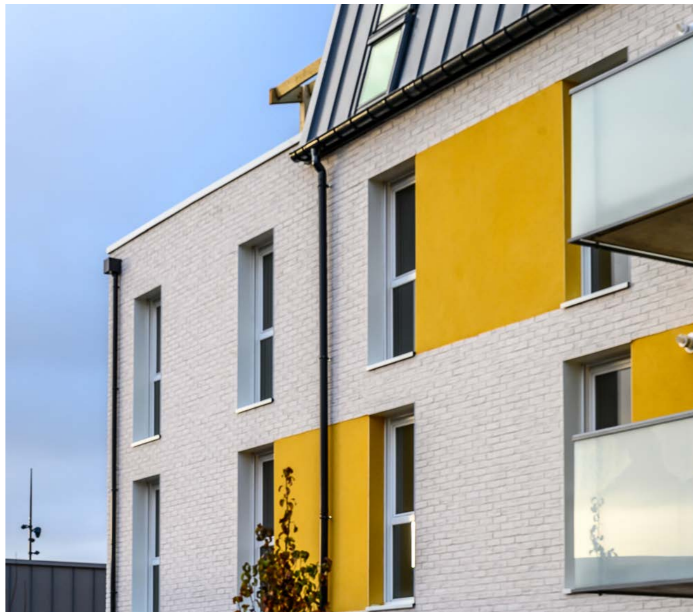
Façade d'un immeuble rénové sur la commune de Cuincy.
