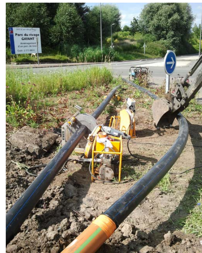
Récupération des eaux pluviales.
