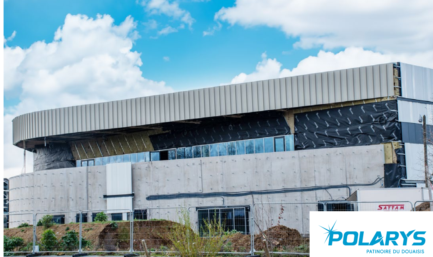
Les façades extérieures sont en cours d'aménagement.
