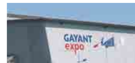
Gestion de Gayant expo et réalisation des travaux afférents
